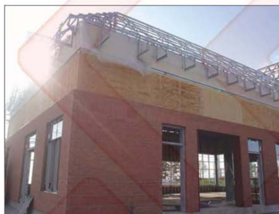
شکل ۱ نمای خارجی و داخلی یک ساختمان در حال ساخت با سازه LSF
