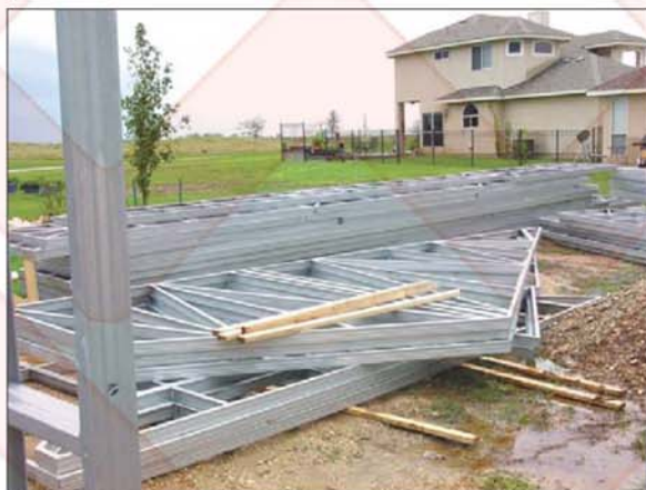
شکل ۹ نمونه قاب‌های مورد استفاده در روش پانلی
