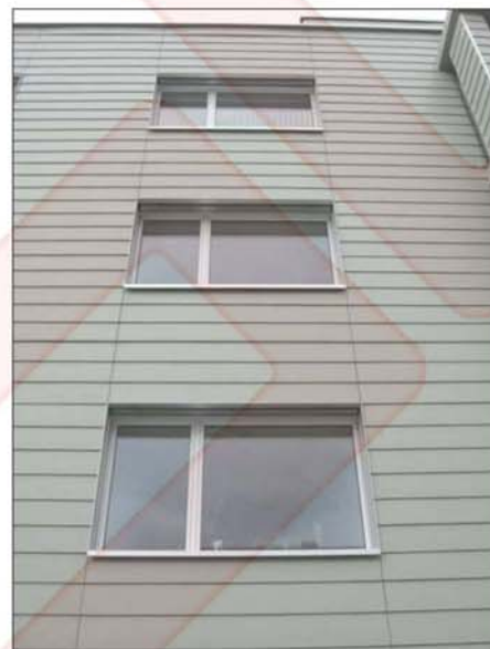
شکل ۴۴ نماهای اجرا شده با تخته‌های سیمانی روی هم (با هم پوشانی)
