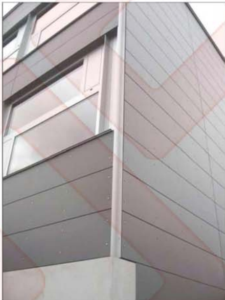
شکل ۴۳ نماهای اجرا شده با تخته‌های سیمانی درزدار
