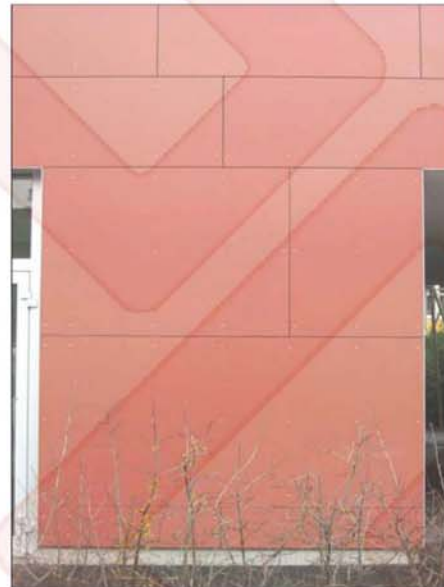
شکل ۴۳ نماهای اجرا شده با تخته‌های سیمانی درزدار
