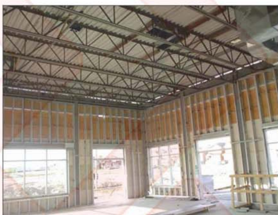
شکل ۱ نمای خارجی و داخلی یک ساختمان در حال ساخت با سازه LSF
