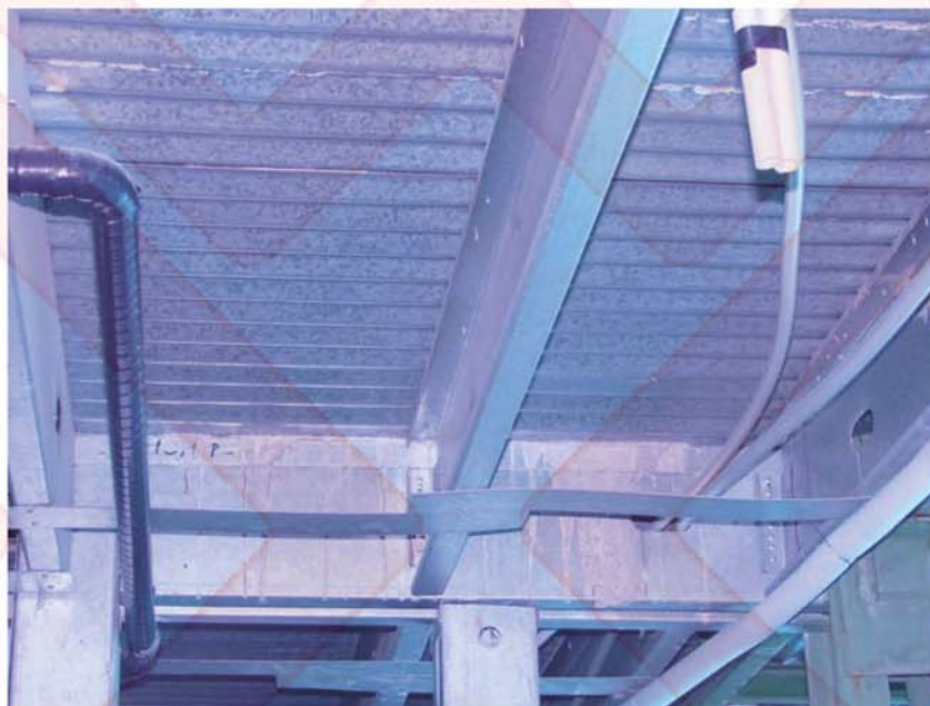
شکل ۵۹ اتصال دال بتن مسلح به تیرچه فلزی به واسطه ورق موج‌دار
