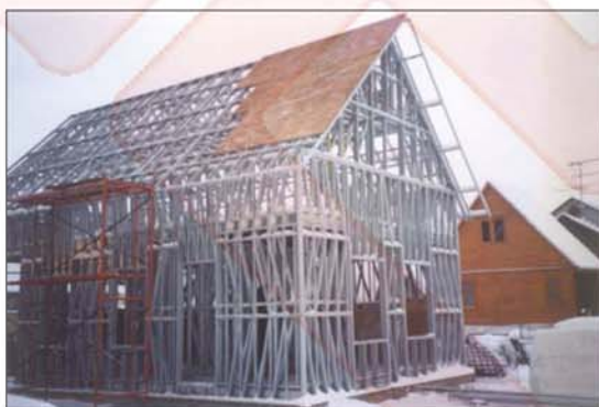
شکل ۱۷ خریاهای تشکیل‌دهنده سقف شیب‌دار
