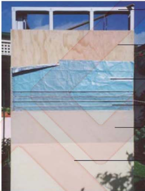
شکل ۶ لایه ها و اجزای تشکیل دهنده یک نمونه جدار خارجی
