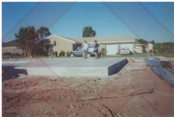
شکل ۷ اجرای شالوده گسترده
