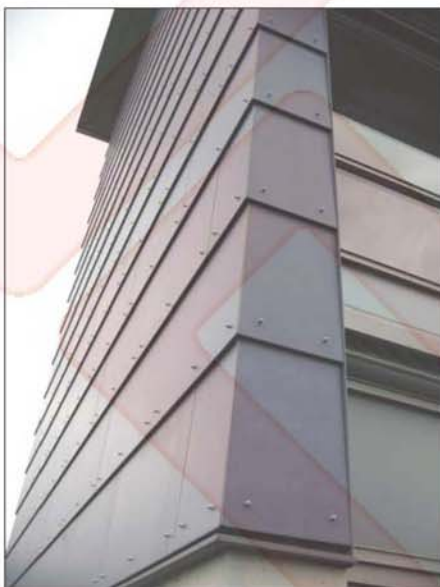
شکل ۴۴ نماهای اجرا شده با تخته‌های سیمانی روی هم (با هم پوشانی)
