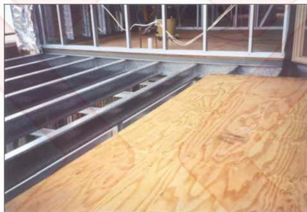
شکل ۳۶ نمونه پوشش نهایی سقف مستوی
