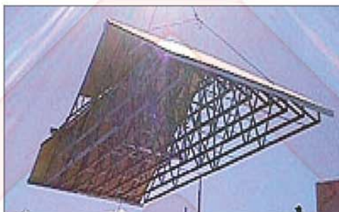
شکل ۱۱ اجرای سیستم جعبه‌ای
