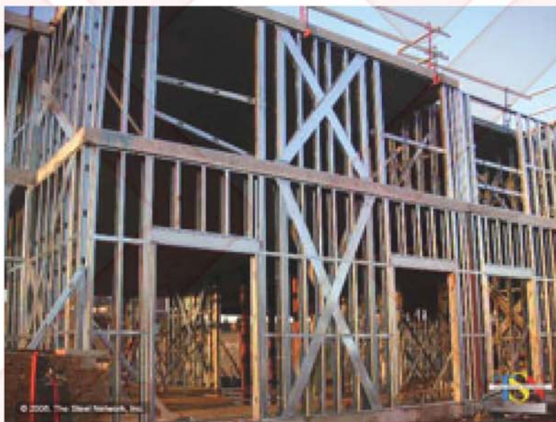
شکل ۵۴ سیستم دهانه مهاربندی شده با اعضای قطری
