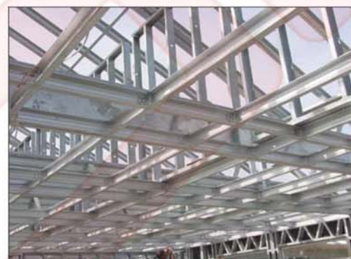
شکل ۱۷ خریاهای تشکیل‌دهنده سقف شیب‌دار
