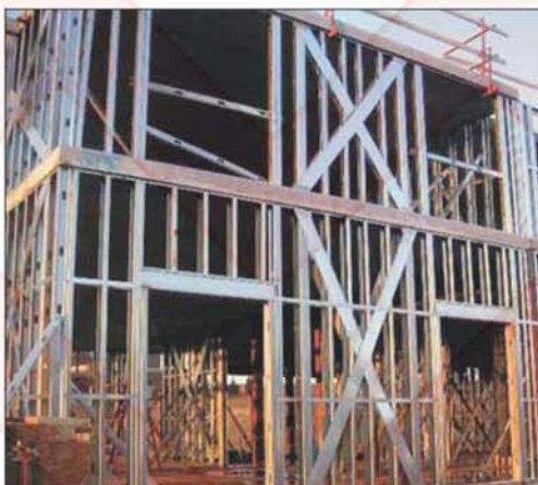
شکل ۱۲ اجزای مهاربندی دیوارها
